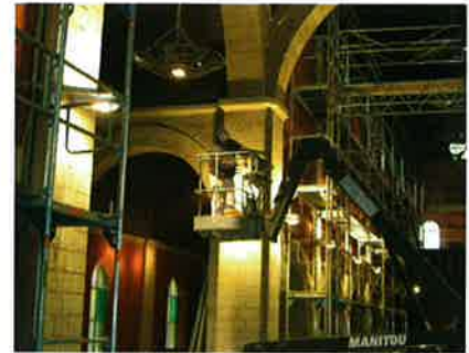
Les travaux ont nécessité une importante logistique
