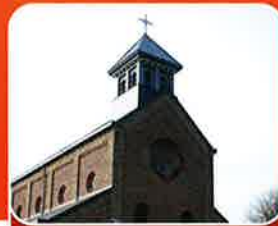
Rénovation de l'église de Ruy
